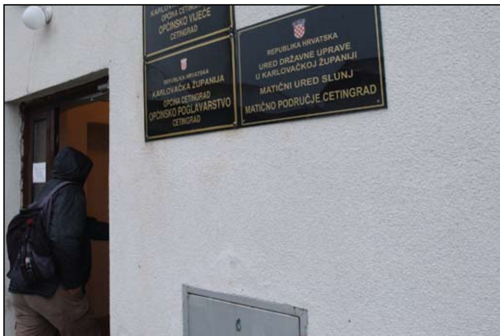
Zgrada Općine Cetingrad u kojoj se posljednjih godina zbio niz nepravilnosti
